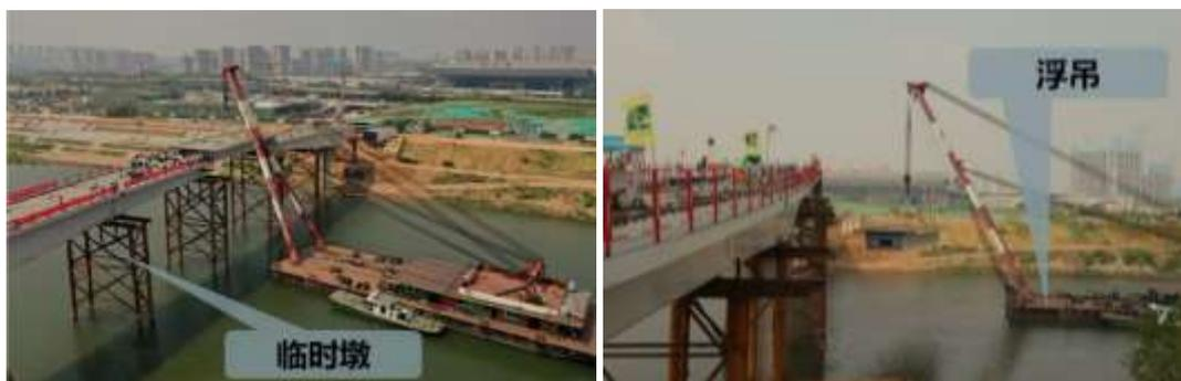
图 2-16 桥梁架设施工示意图（本图为示意图非本工程实际实施情况）
