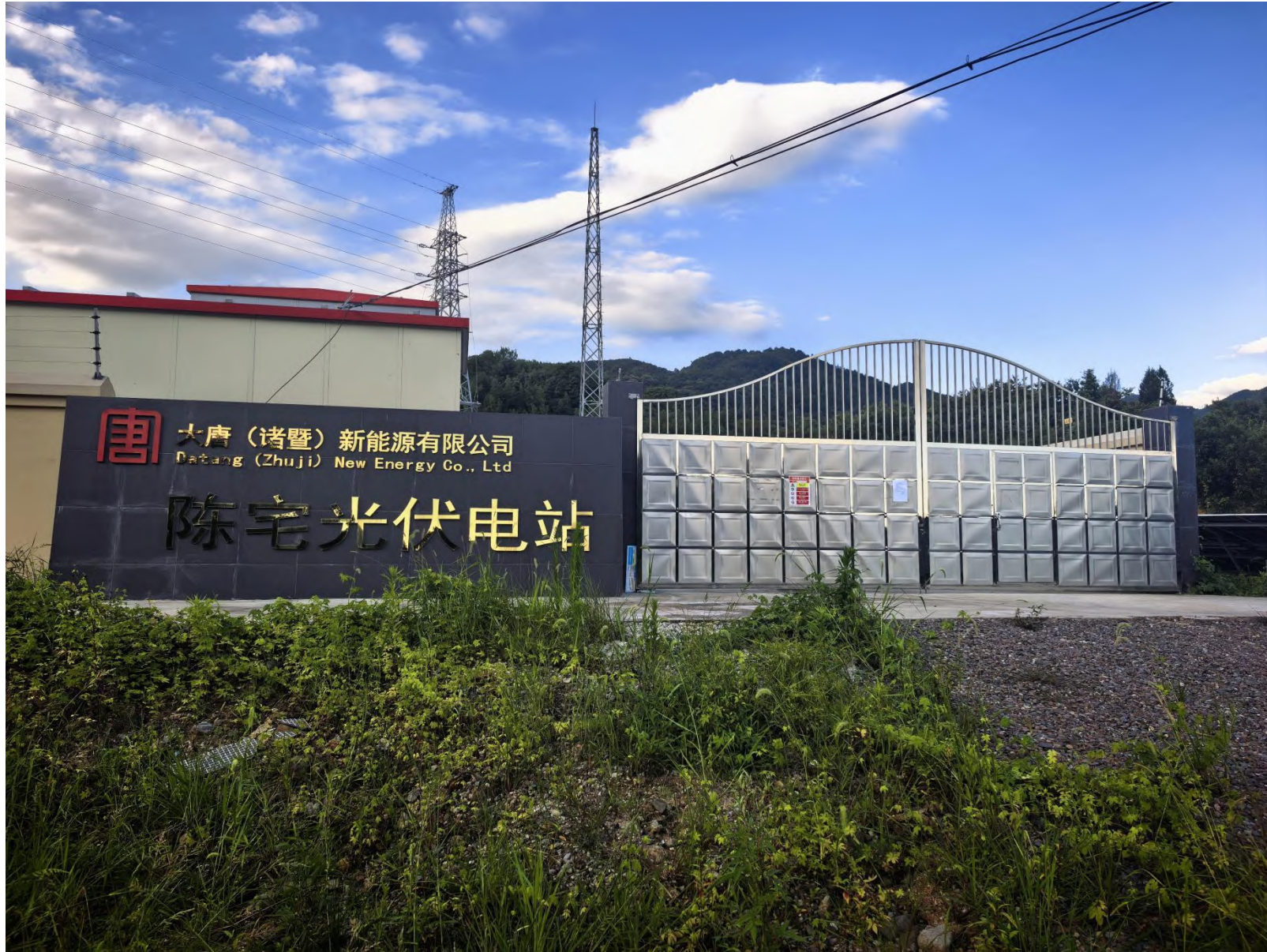
附图 7 项目竣工及调试公示照片
