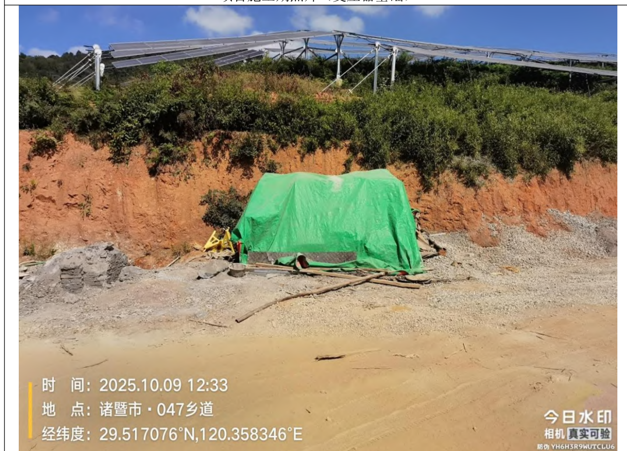
项目施工期照片（临时堆料场）
