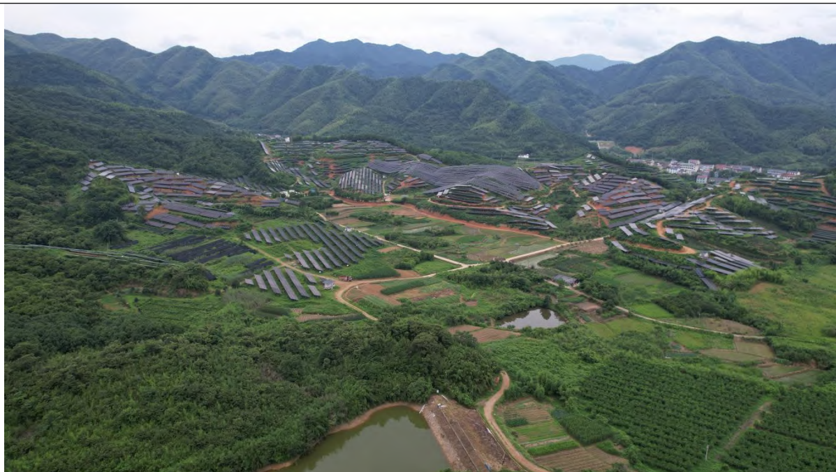
光伏场俯瞰图
