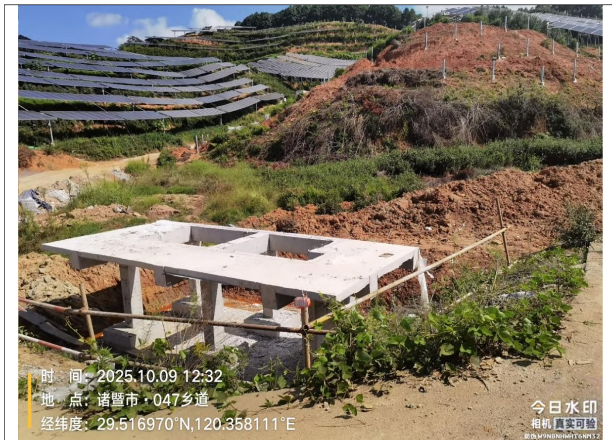
项目施工期照片（变压器基础）
