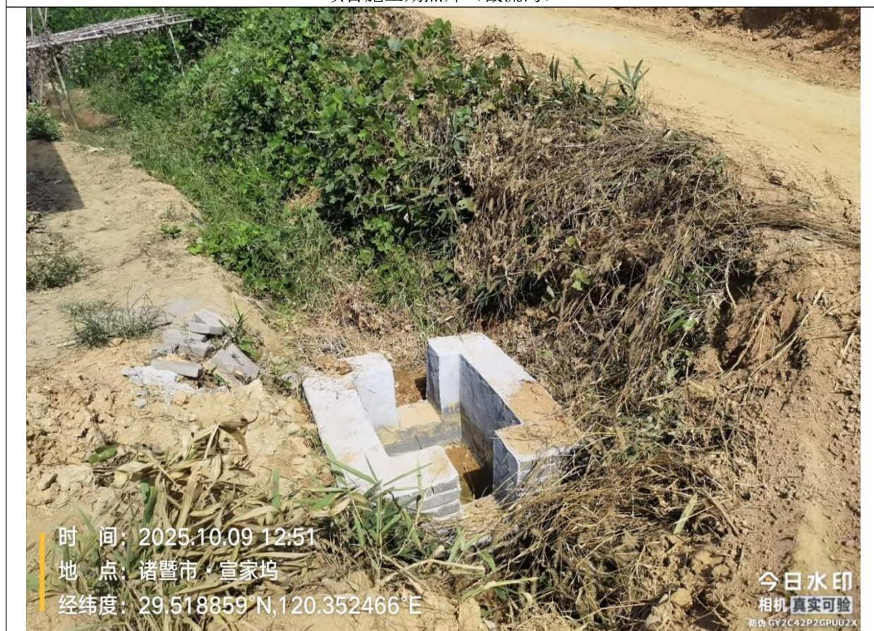
项目施工期照片（沉淀池）
