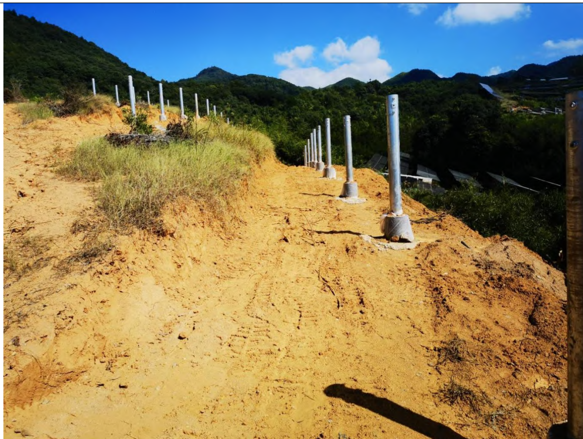
项目施工期照片（支架）
