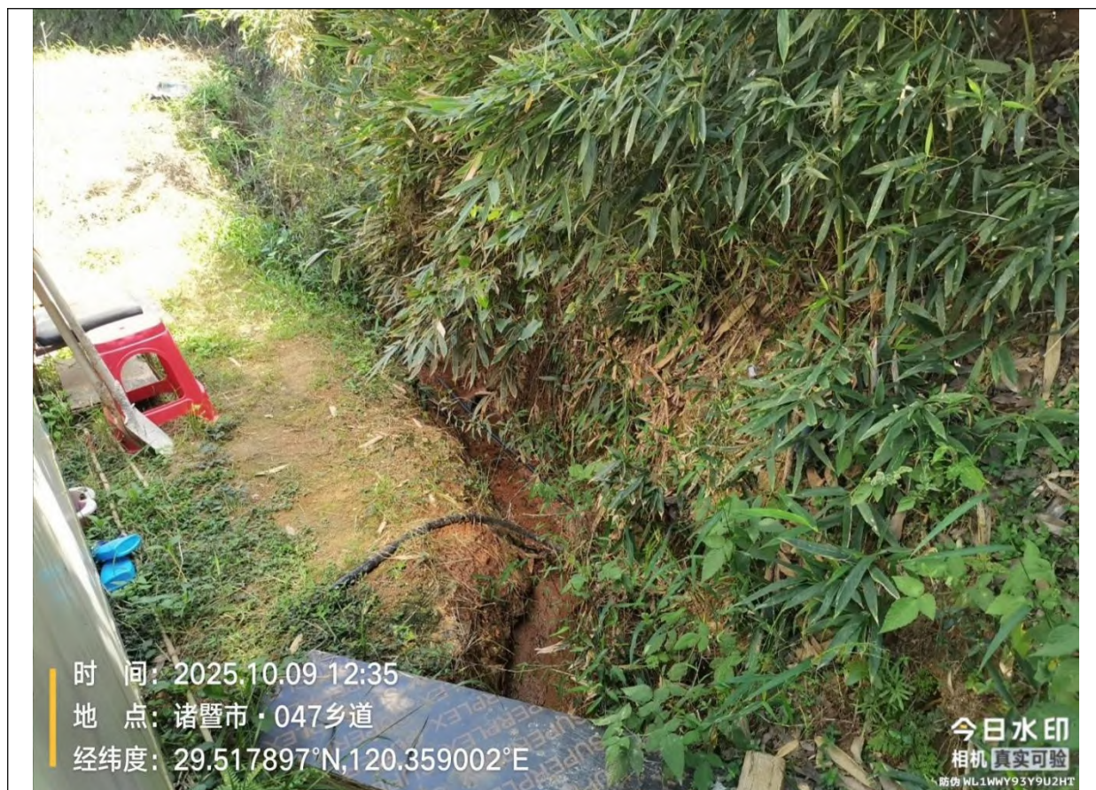
项目施工期照片（截流沟）
