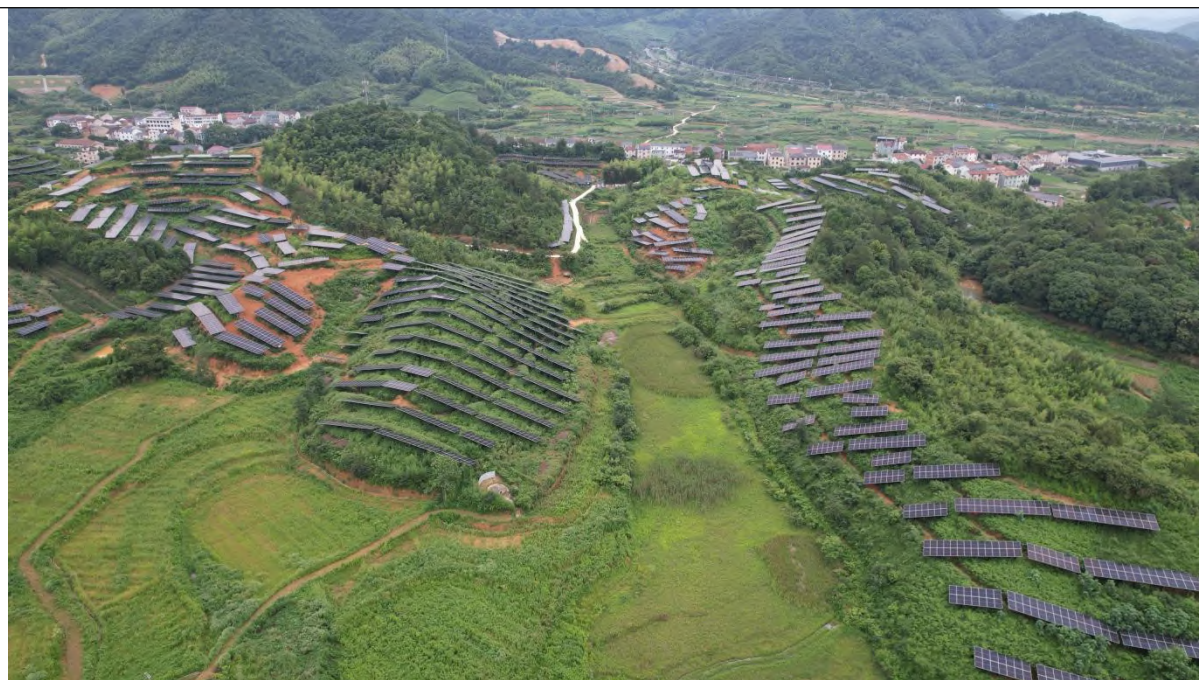
光伏场俯瞰图
