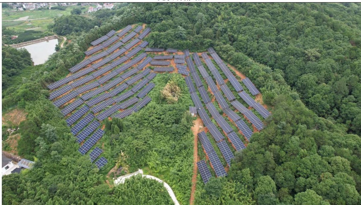
光伏场俯瞰图
