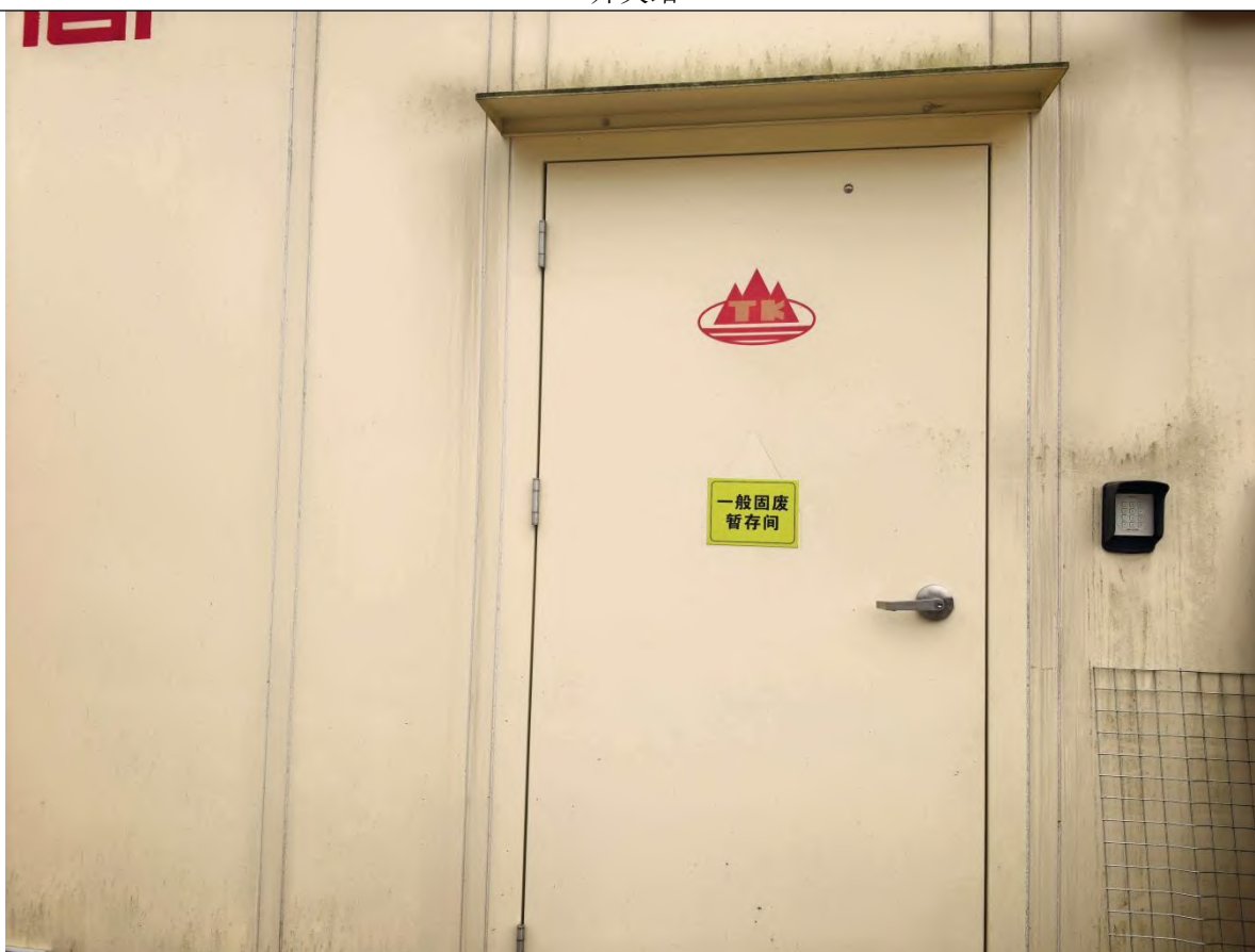
开关站一般固废暂存间
