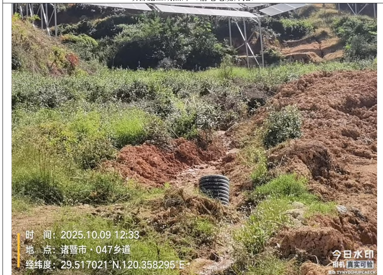
项目施工期照片（输电电缆定向钻施工）
