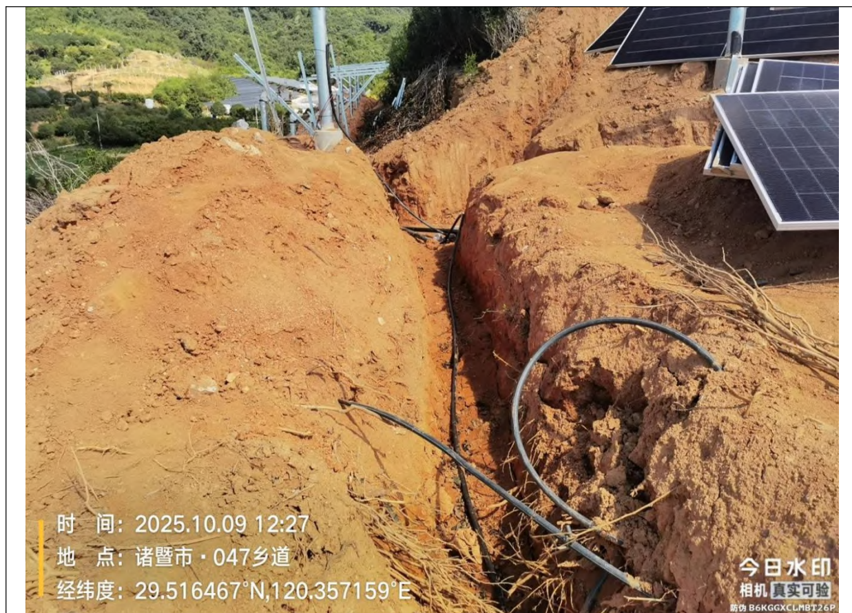
项目施工期照片（输电电缆开挖）
