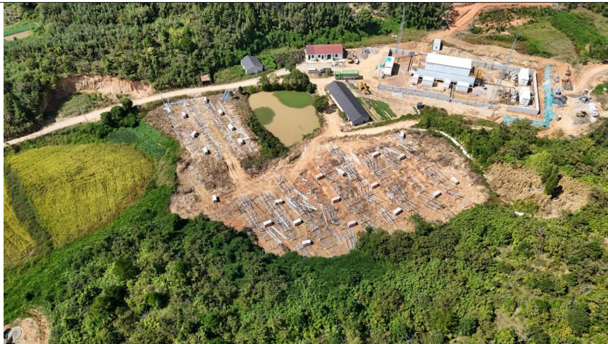
项目施工期照片（开关站附近）
